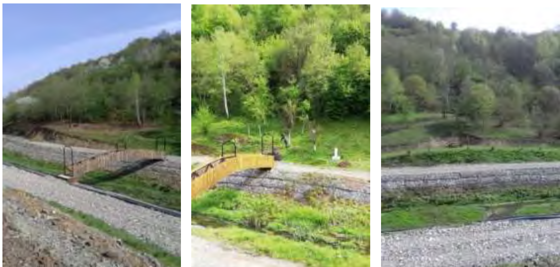
Слика 6.22. Обод канала и мостић
