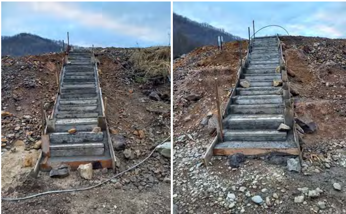
Слика 6.45. Пејзажне степенице у изградњи
