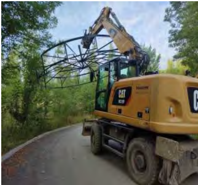
Слика 6.60 Колаж слика замене решетке изнад колектора
