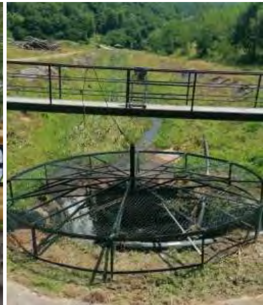
Слика 6.60 Колаж слика замене решетке изнад колектора
