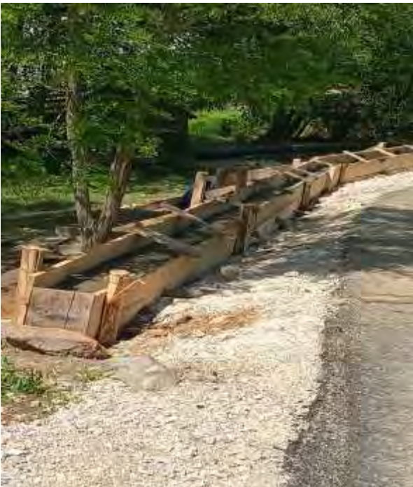
Слика 6.75 Асфалтирање и постављање потпорног зида
